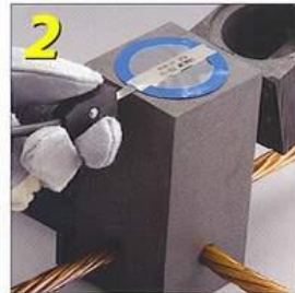
2 Conecte la terminal de la unidad de control a la tira de ignición
