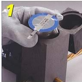
1 Inserte el contenedor metálico de CADWELD PLUS dentro del molde (requiere el uso de una cubierta / baffle)
